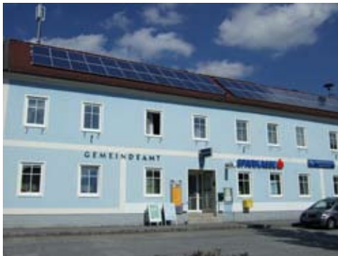
Photovoltaikanlage auf dem Dach des Gemeindehauses:
