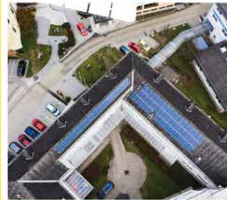
z. B. PV-Anlage: TBZ Groß-Siegharts
