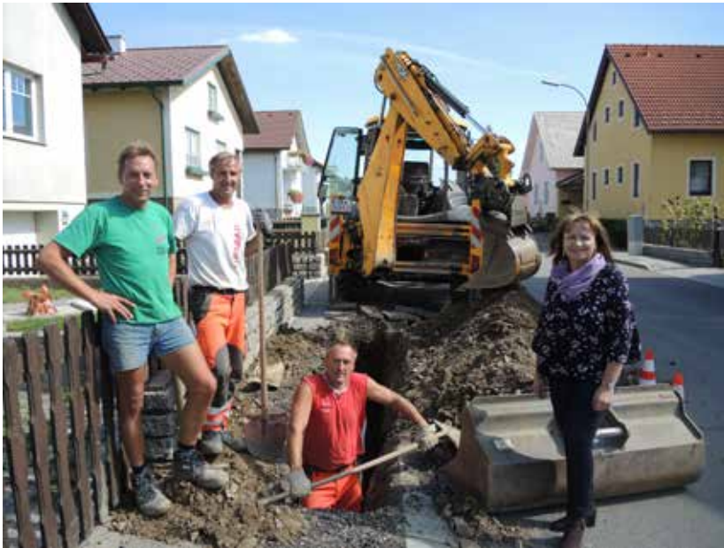
Mitarbeiter der Firma Strabag mit Bürgermeisterin Anette Töpfl
