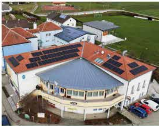
z. B. PV-Anlage: Kommunalzentrum Gastern
